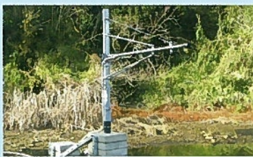
ため池の所定場所に設置した水位センサー
